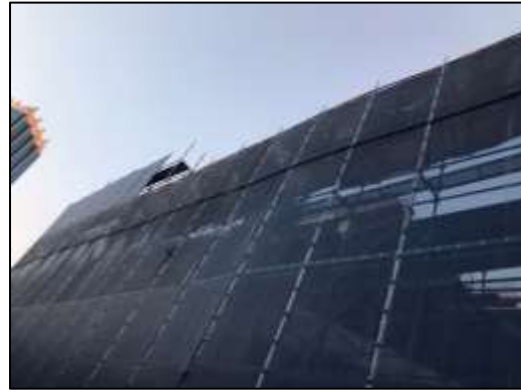
ภาพที่ 14 ผ้าใบก่อสร้าง (Mesh Sheet) ปิดคลุมอาคาร
