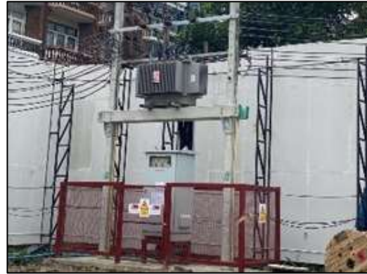
ภาพที่ 51 หม้อแปลงไฟฟ้า
