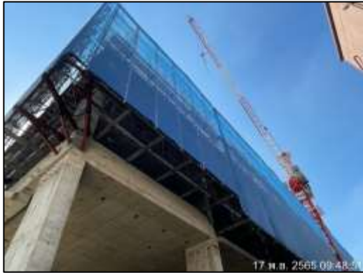
ภาพที่ 14 ผ้าใบก่อสร้าง (Mesh Sheet) ปิดคลุมอาคาร
