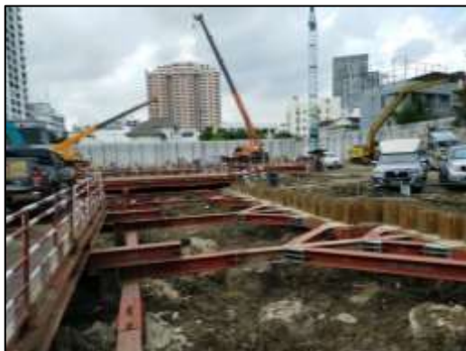
ภาพที่ 29 Sheet pile และเหล็กค้ำยัน (Bracing)
