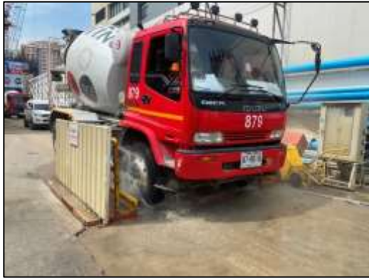
ภาพที่ 22 พื้นที่และกิจกรรมฉีดล้างล้อรถบรรทุก
