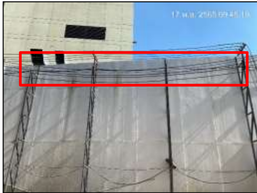
ภาพที่ 17 สเปรย์น้ำบริเวณรั้ว Metal Sheet รอบโครงการ
